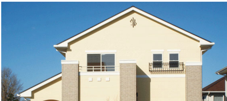
■東宝ホーム 施工例
