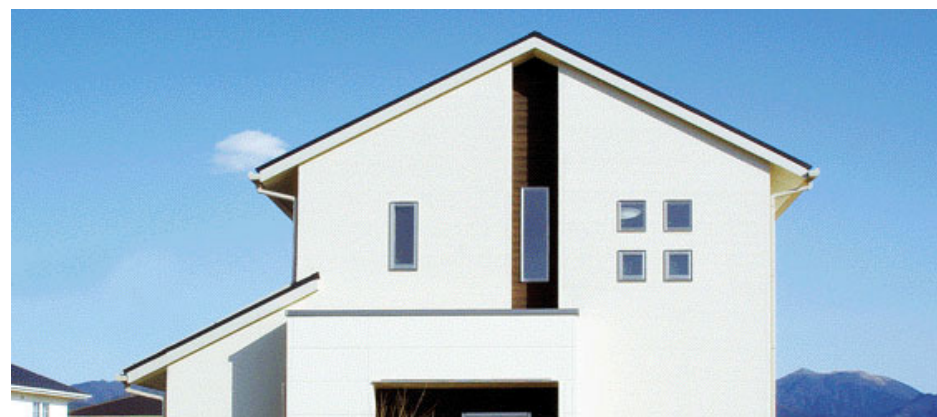
■東宝ホーム 施工例
